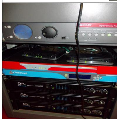
Maintenant, le son numérique est à l'intérieur d'un disque dur. Il est diffusé par des amplis de puissance.
